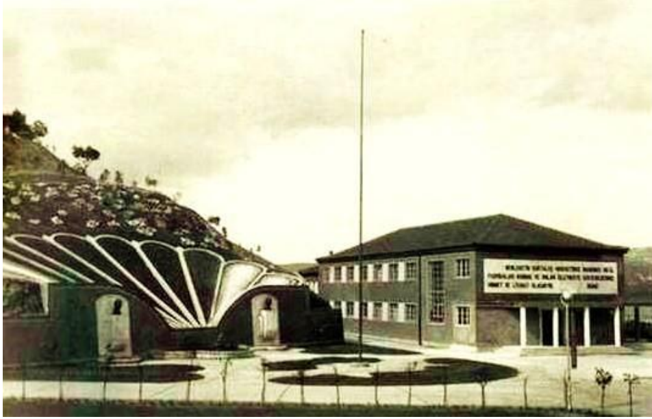
Sunğıpek Fabrikası İdare Binası (1950). Fotoğraf
